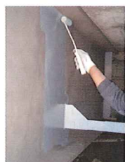
ブラスト面に ローラーで ジンクリッチ塗装
