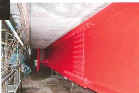
ブラスト面に ローラーで ジンクリッチ塗装
